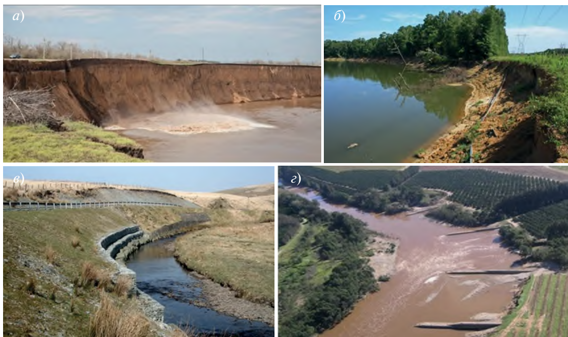
Рис. 1. Примеры плановых русловых деформаций на меандрирующих реках — а и б ; берегозащитные сооружения — в и г
