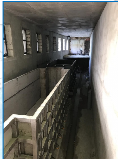
Строящийся научно-исследовательский комплекс
