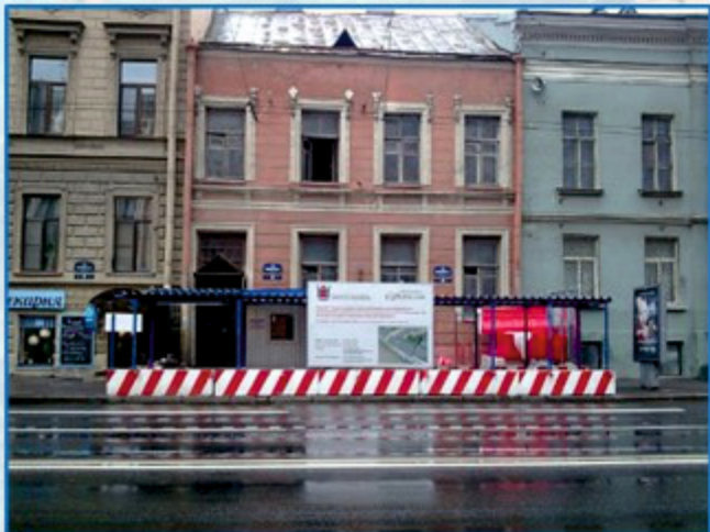
Здание СПбФ ИО РАН – начало реконструкции. Фасад с 1-ой линии В.О.
