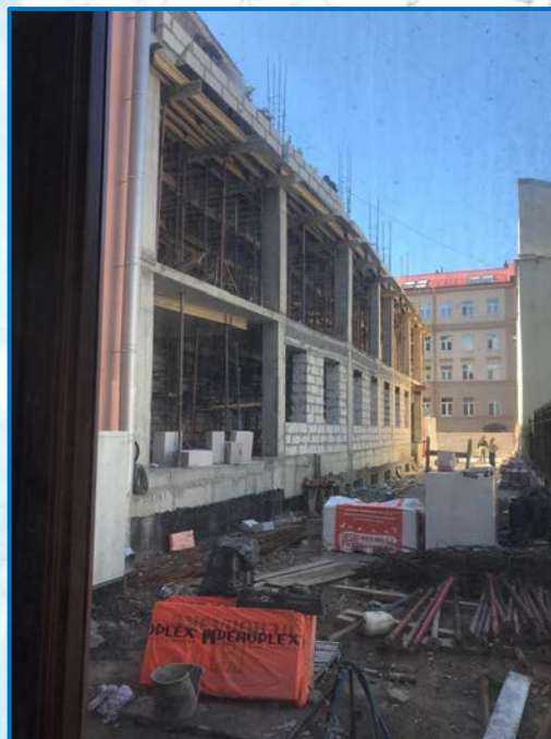
Строительство здания с ул. Репина
