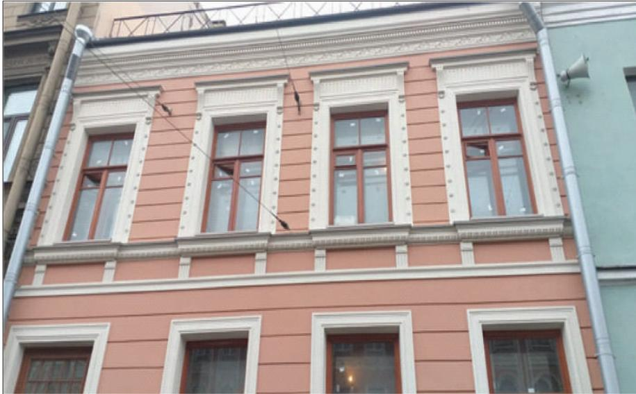
Рисунок 26 — Восстановление утраченных элементов на фасаде.
