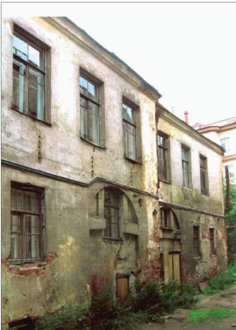
Рисунок 19 — Корпус «Б» (дворовый). Северная стена. Сохранилось историческое положение наружных капитальных стен, габариты оконных проёмов 2-го этажа.
