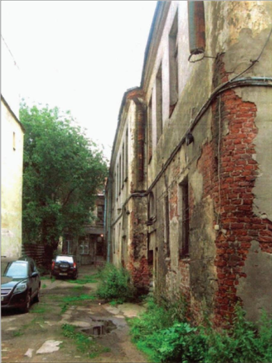
Рисунок 20 — Общий вид дворовой территории. Сохранился планировочный контур двора. На дворовом корпусе многочисленные утраты штукатурного слоя, трещины, утраты кирпичной кладки. Фото 09.08.2012.
