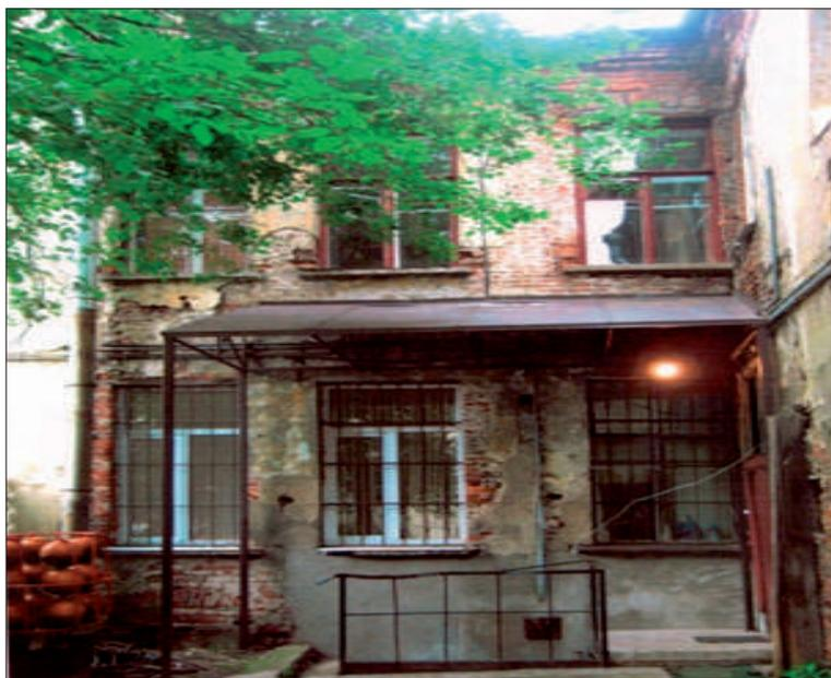
Рисунок 18 — Корпус «А» (лицевой). Дворовый фасад. Хорошо видны прикладки к простенкам между оконными проёмами, выполненные при перестройках здания. Фото 09.08.2012.
