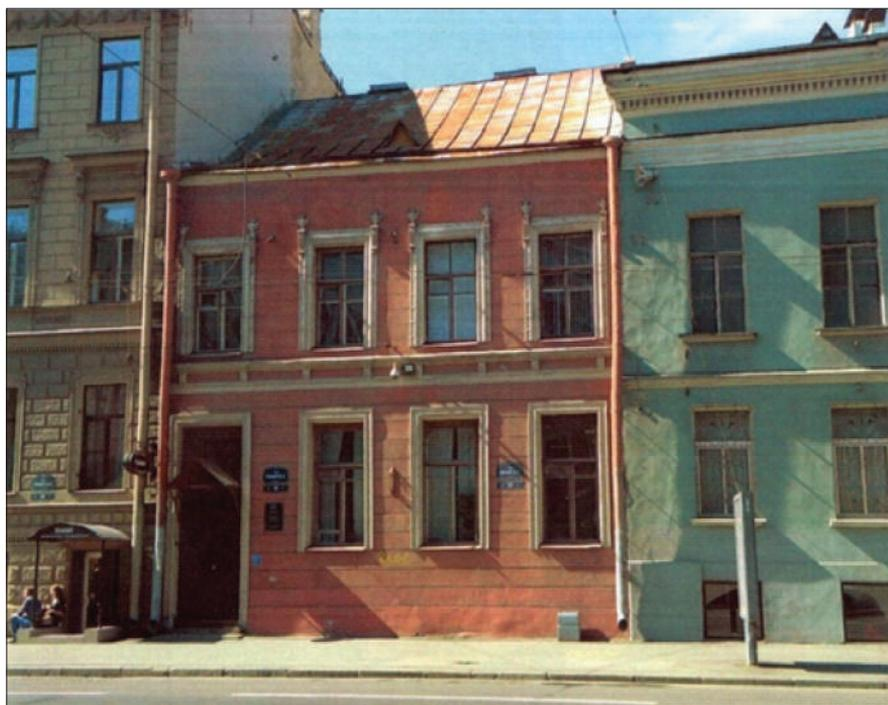
Рисунок 17 — Корпус «А» дома 30 (лицевой). Фасад по 1-й линии В.О. Реконструкция 1960-х гг. Над кронштейнами установлены лепные изображения ваз, сделан новый узкий карниз небольшого выноса, заложены окна подвального этажа. Фото 09.08.2012.
