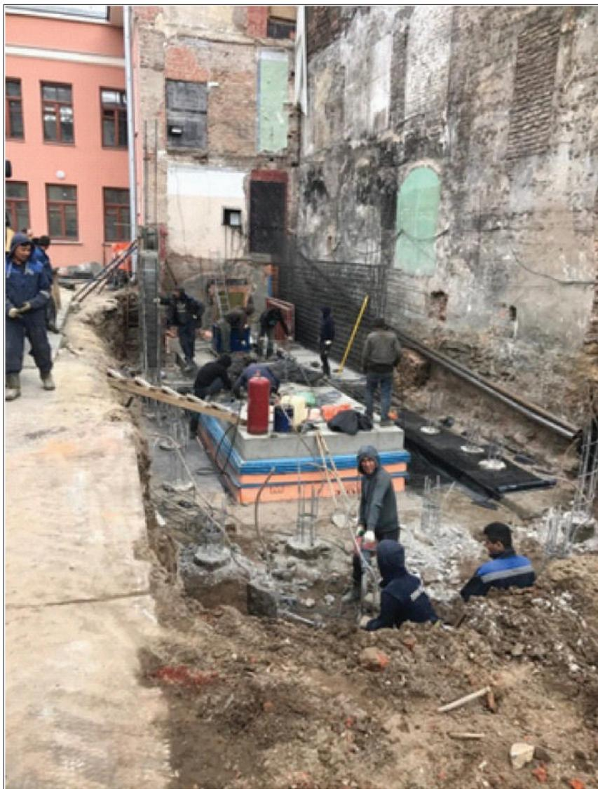
Рисунок 30 — Устройство фундаментов.
